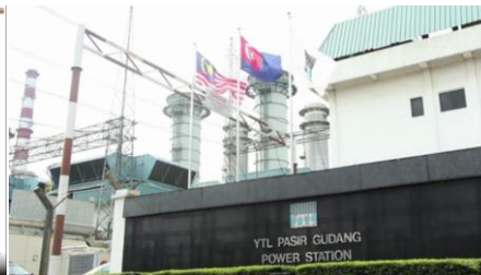
Fig. 1. (d) Visit to power station
